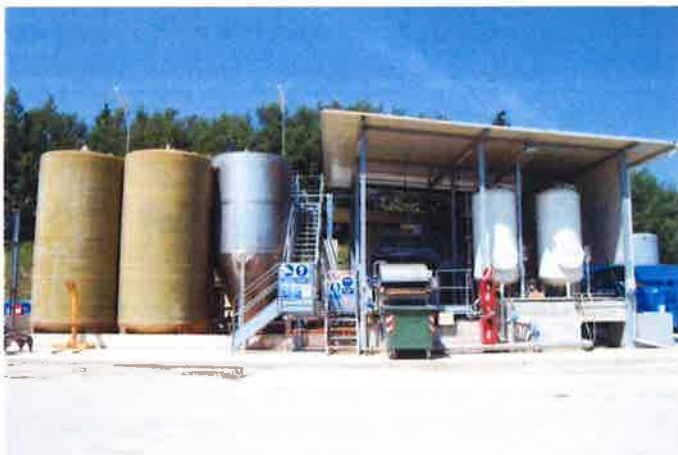
Figura 6: IMPIANTO DI TRATTAMENTO CHIMICO-FISICO (D9)
